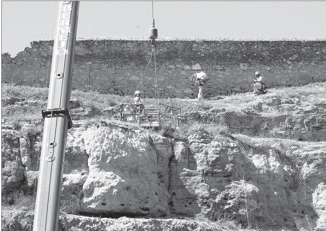
Los operarios de Ortiz Construcciones y Proyectos ultiman los trabajos en la parte superior del roquedo
