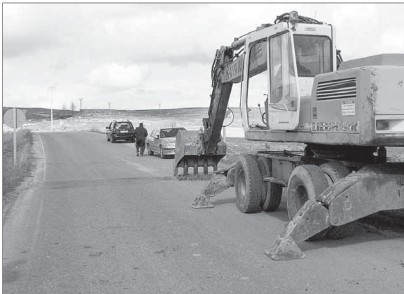
Asetra acometió el arreglo del badén de la carretera del vertedero en marzo pasado
