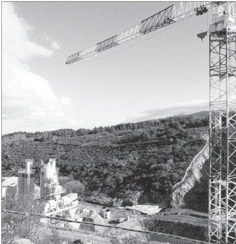
La presa se está construyendo en el término de Aldealengua de Pedraza
