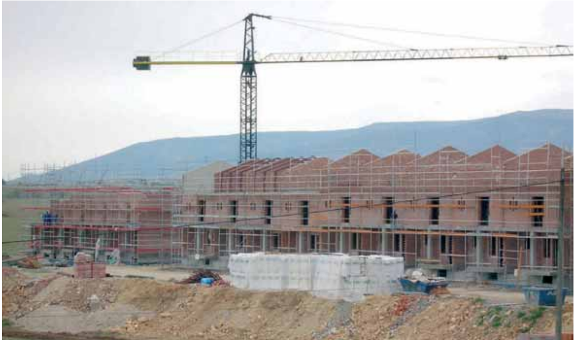
Vista parcial de residencial 'Los Escobares', actualmente en fase de ejecución / EL ADELANTADO
