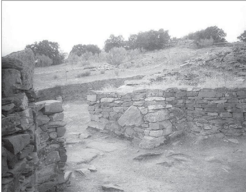
Estado actual de la zona arqueológica del Cerro de la Virgen del Castillo
