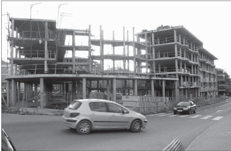
La construcción del edificio permanece paralizada desde julio de 2000
