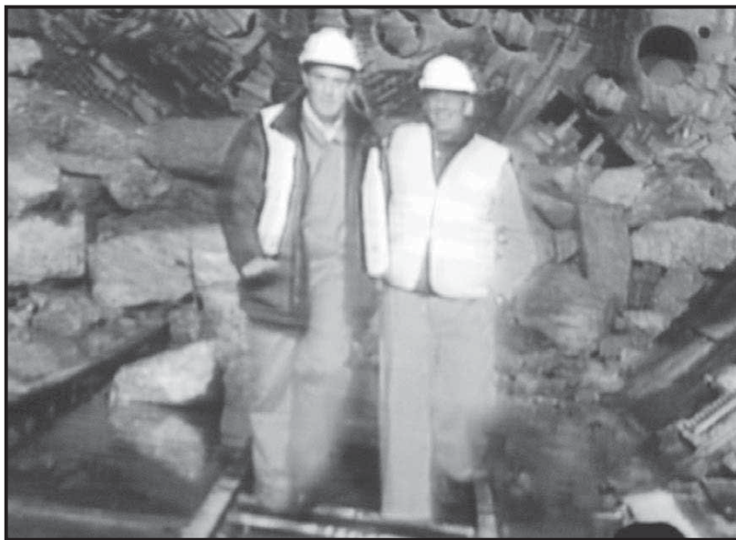
Los dos trabajadores, caminan juntos tras convertirse los dos túneles en uno solo
