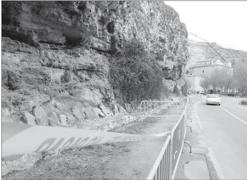
La nueva zona permanece vallada mientras la empresa Ortiz continúa los trabajos en el Santuario. FERNANDO PEÑALOSA
