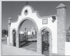
Ctra. de La Granja-Torrecaballeros Telfs. 921 12 02 18 y 921 40 11 61
