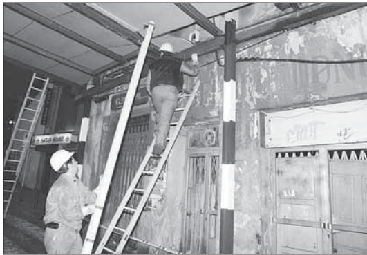
Dos operarios procedieron a aislar los cables eléctricos PENALOSA
