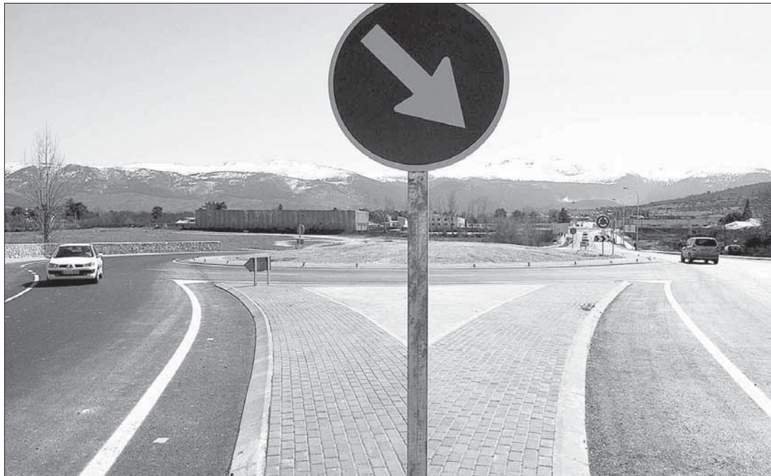
La primera de las nuevas rotondas, en sentido La Granja, servirá para acceder a la urbanización de Peñas del Erizo
