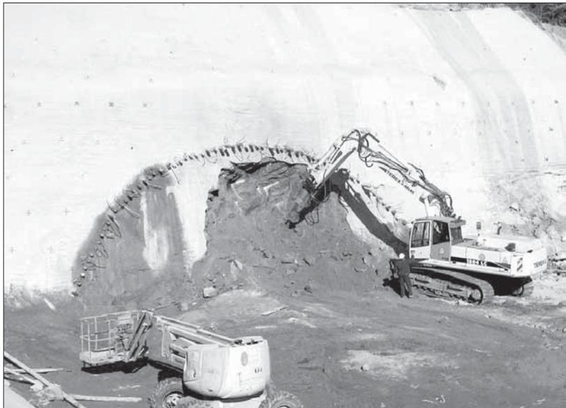
Las labores de excavación van acompañadas de consolidación y cosido del terreno
