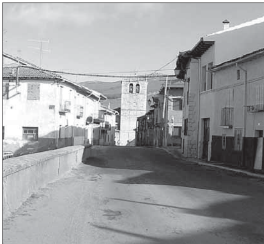
Estado actual de la travesía de Rianza
