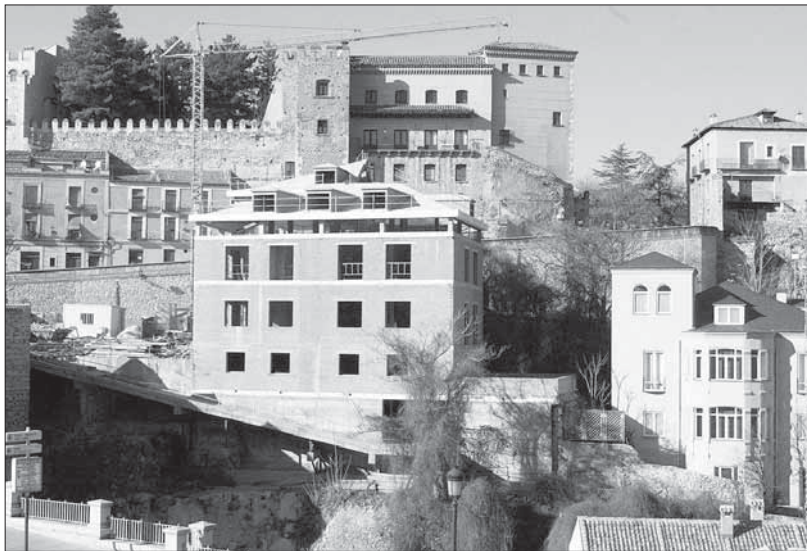
La Junta ejecutó la orden de paralización de las obras del edificio el 29 de diciembre
