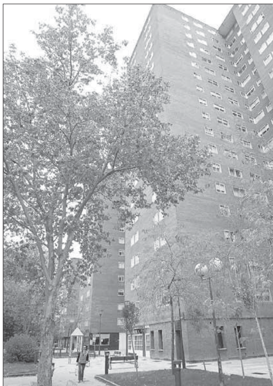
Un bloque de viviendas situado en el Barrio Alto del Ave María en Palencia. / O.N.
