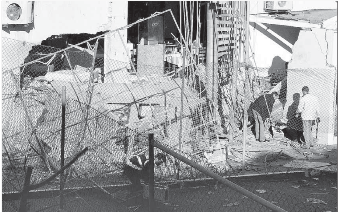
Una bomba reivindicada por ETA causó daños materiales en la fachada del Hotel Port Denia e hirió a una persona. /PEP MORELL (EFE)
