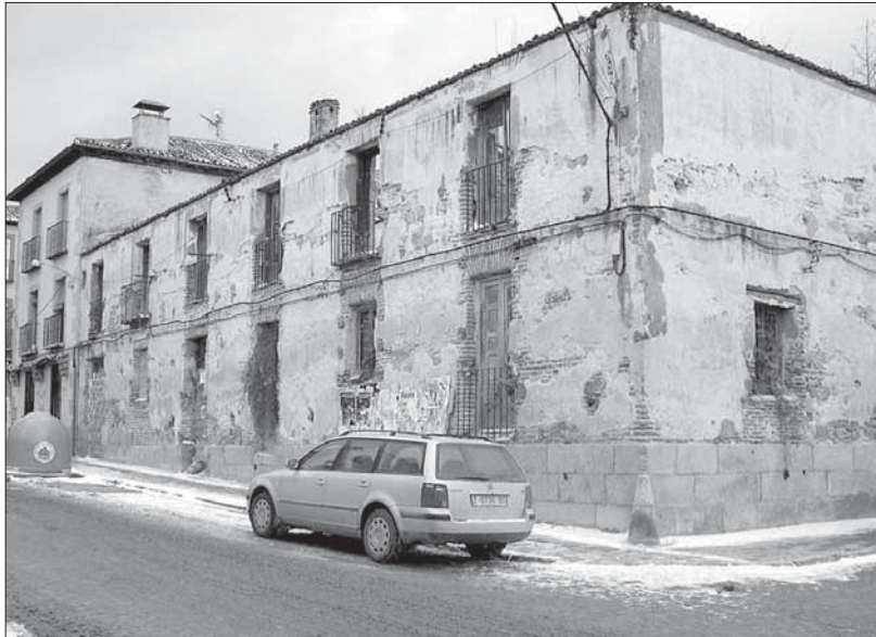
La Casa Cárcel se encuentra en la actualidad en estado de ruina
