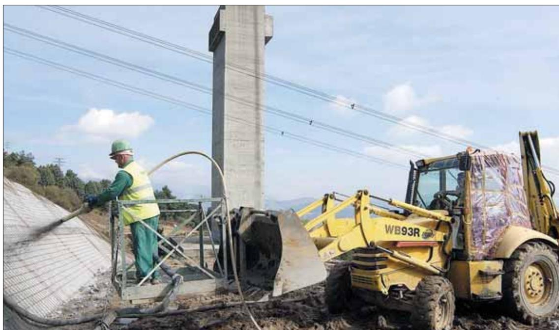
Un trabajador durante una operación de hormigonado, ayer, en la trinchera de la boca sur del futuro túnel de Guadarrama
