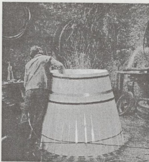
Templando las duelas al hogar de la lumbré, para hacer los toneles y cubas de madera, método tradicional aún utilizado por los toneleros.
