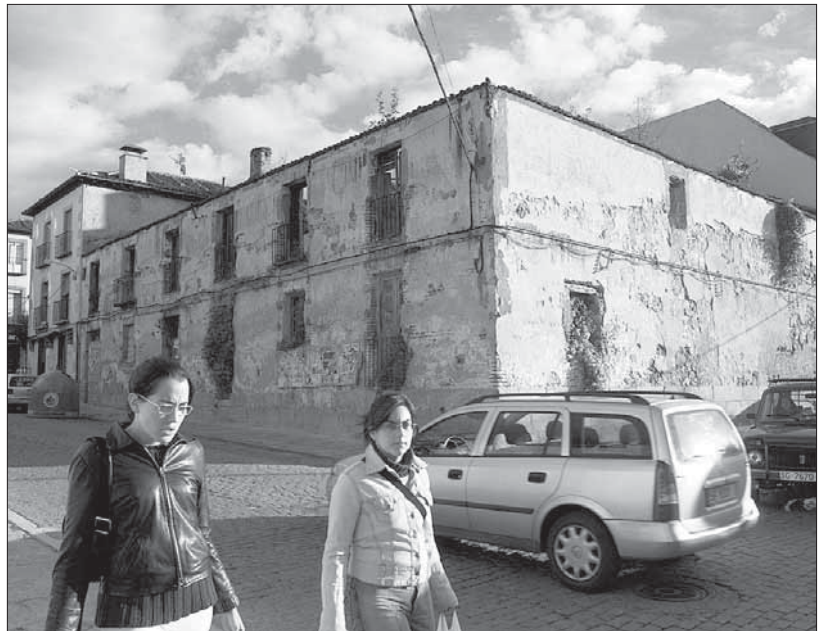
La antigua Casa Carcel de La Granja se encuentra en ruinas en la actualidad
