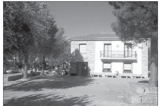
Desde el Ayuntamiento se espera que se concluya en un año A.P.
