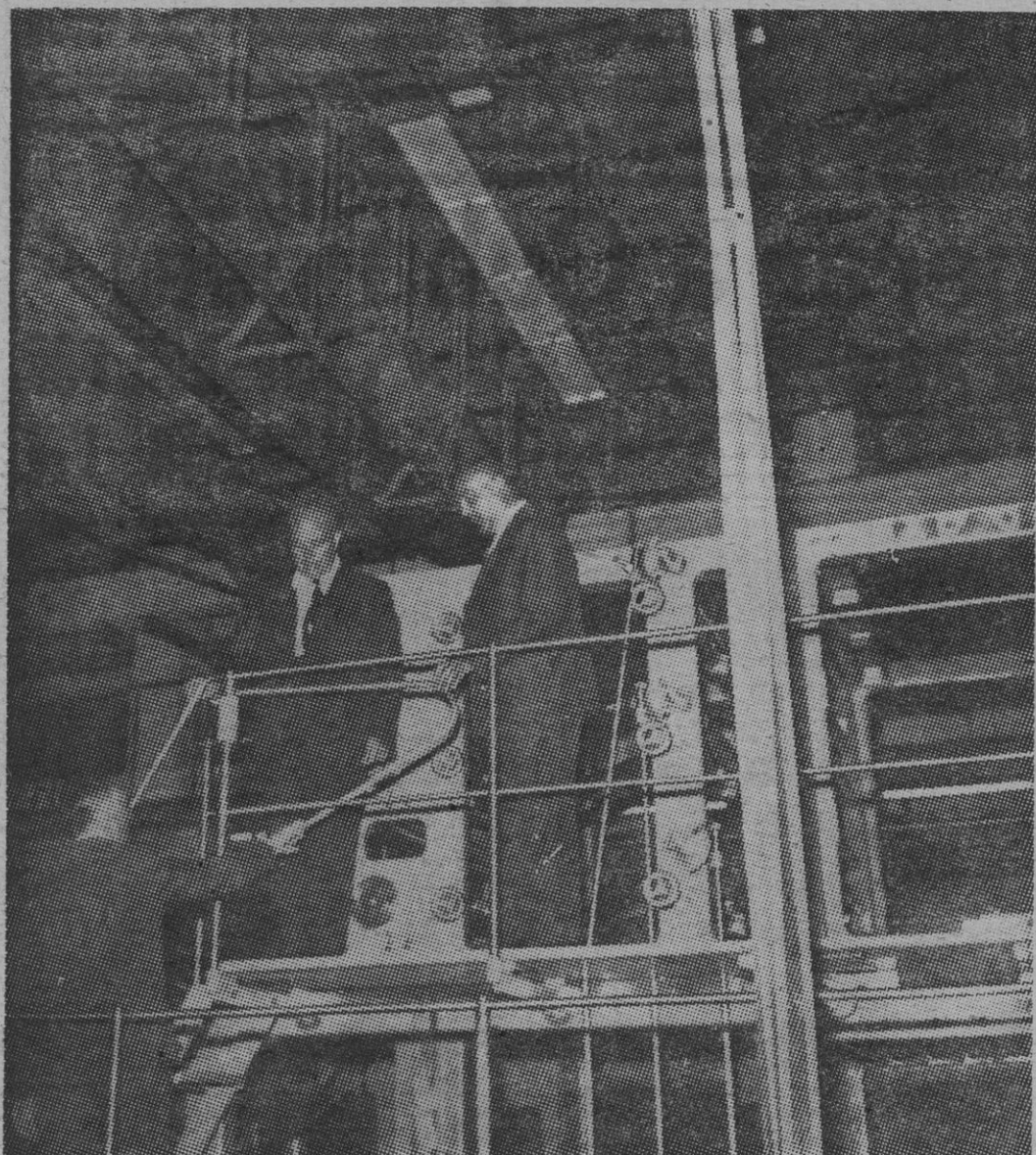
Solis y Lamata, en la rotativa recién instalada en el nuevo edificio de PUEBLO. (Foto Mamegan.)
