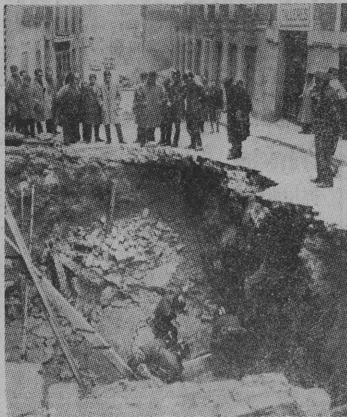
En la calle de Factor, número 10, y a causa de una rotura en la tubería de conducción de agua, se ha originado un enorme socavón, que puso en peligro, en los primeros momentos, la finca enclavada en ese número.
