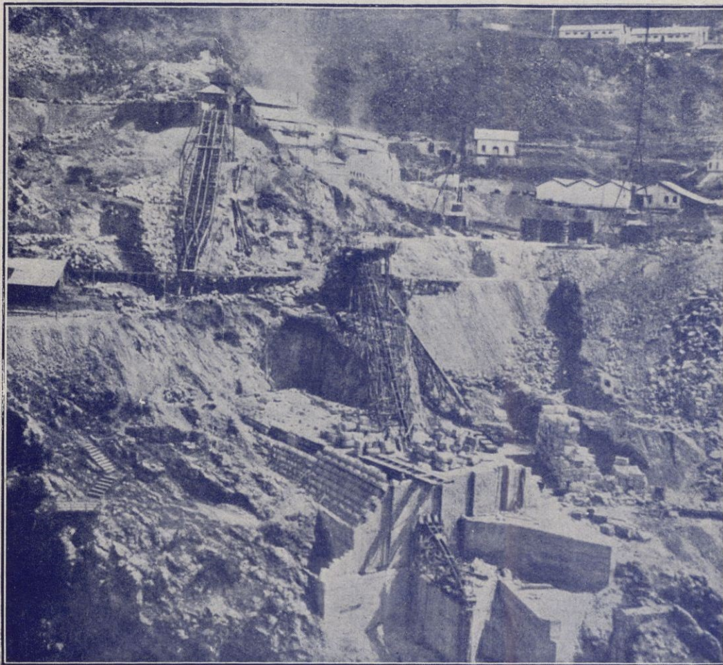
Obras del Pantano del Tranco de Beas - Empresa Constructora AGROMAN, S. A., Madrid
