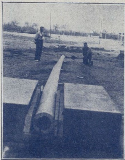
Prueba a la flexión de un poste de 10 metros
