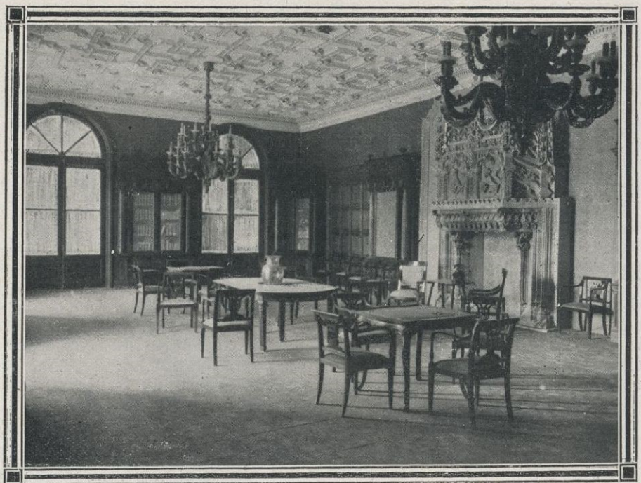
Barcelona : Biblioteca del Palacio Real de Pedralbes
