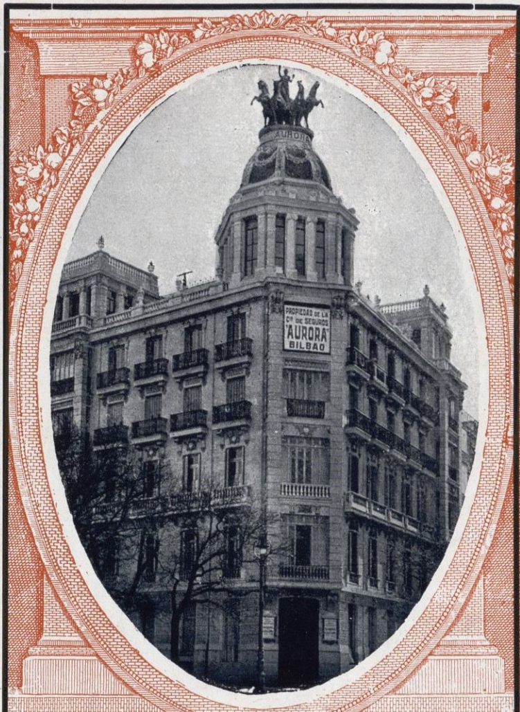
Edificio propiedad de la Compañía en Madrid Paseo de Recoletos
