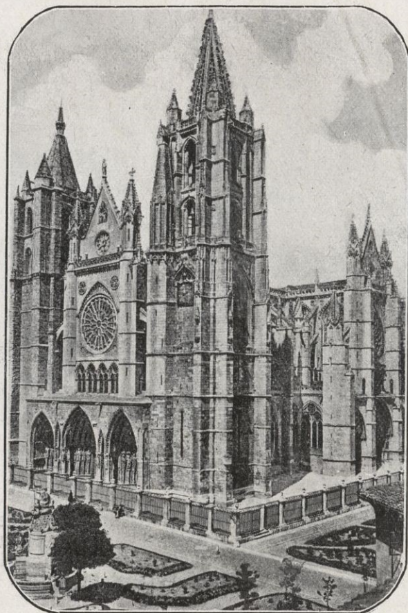
LEÓN : Fachada principal de la Catedral
