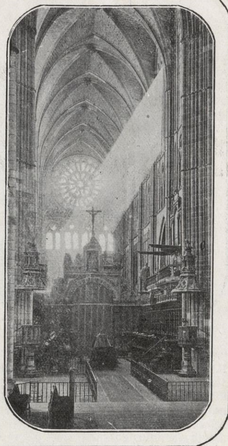
LEÓN : Nave central de la Catedral
