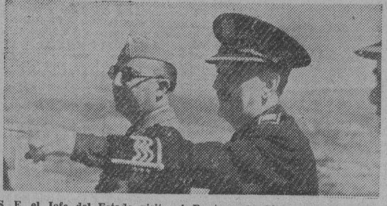
S. E. el Jefe del Estado visita el Pantano de Cijara, que embalsará quinientos cuarenta millones de metros cúbicos de agua, para el regadío de cien mil hectáreas. El ministro de Obras Públicas explica al Caudillo, sobre el terreno, las características del Pantano.—(Foto Cifra)
