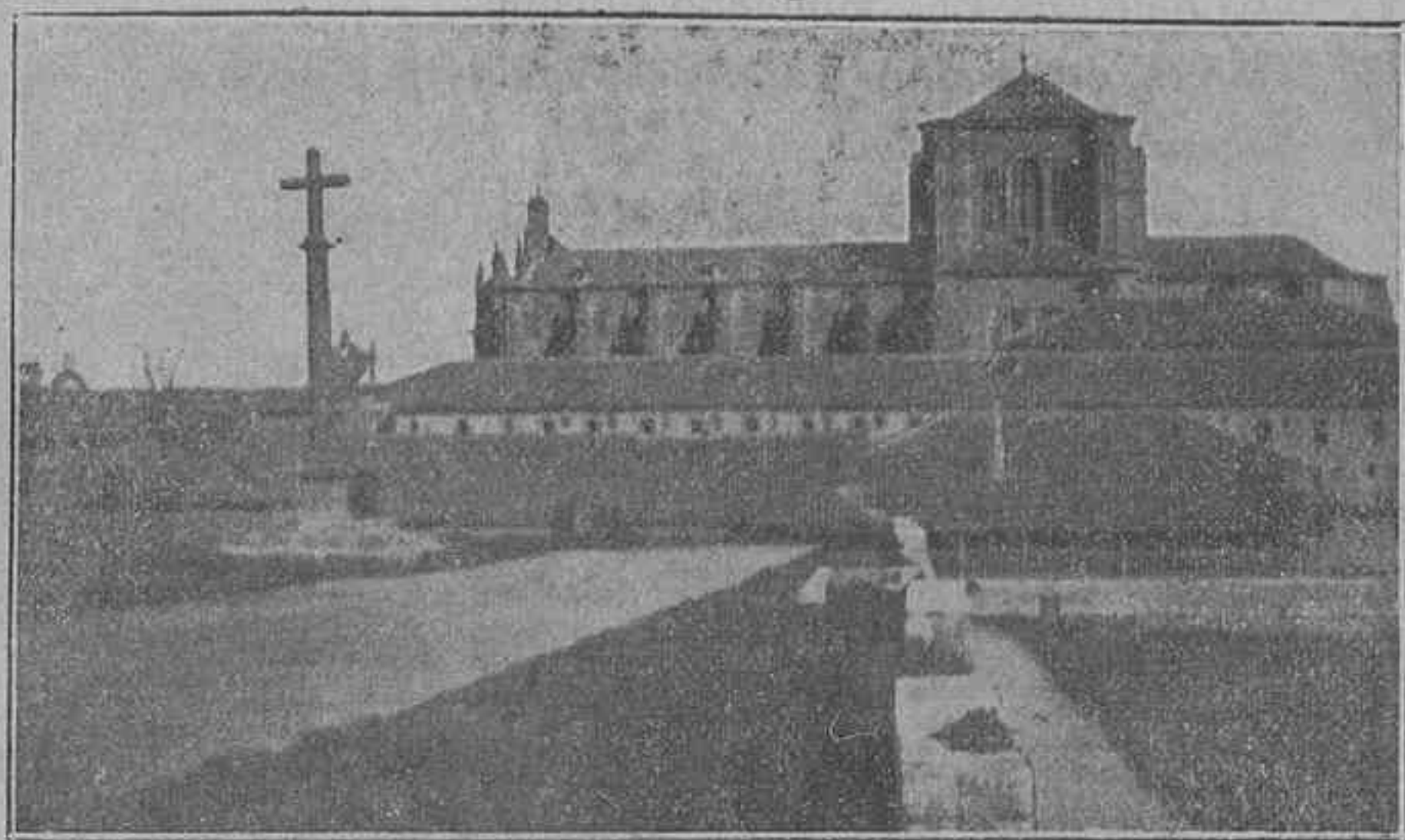
Vista general del Convento de Dominicos de Salamanca
