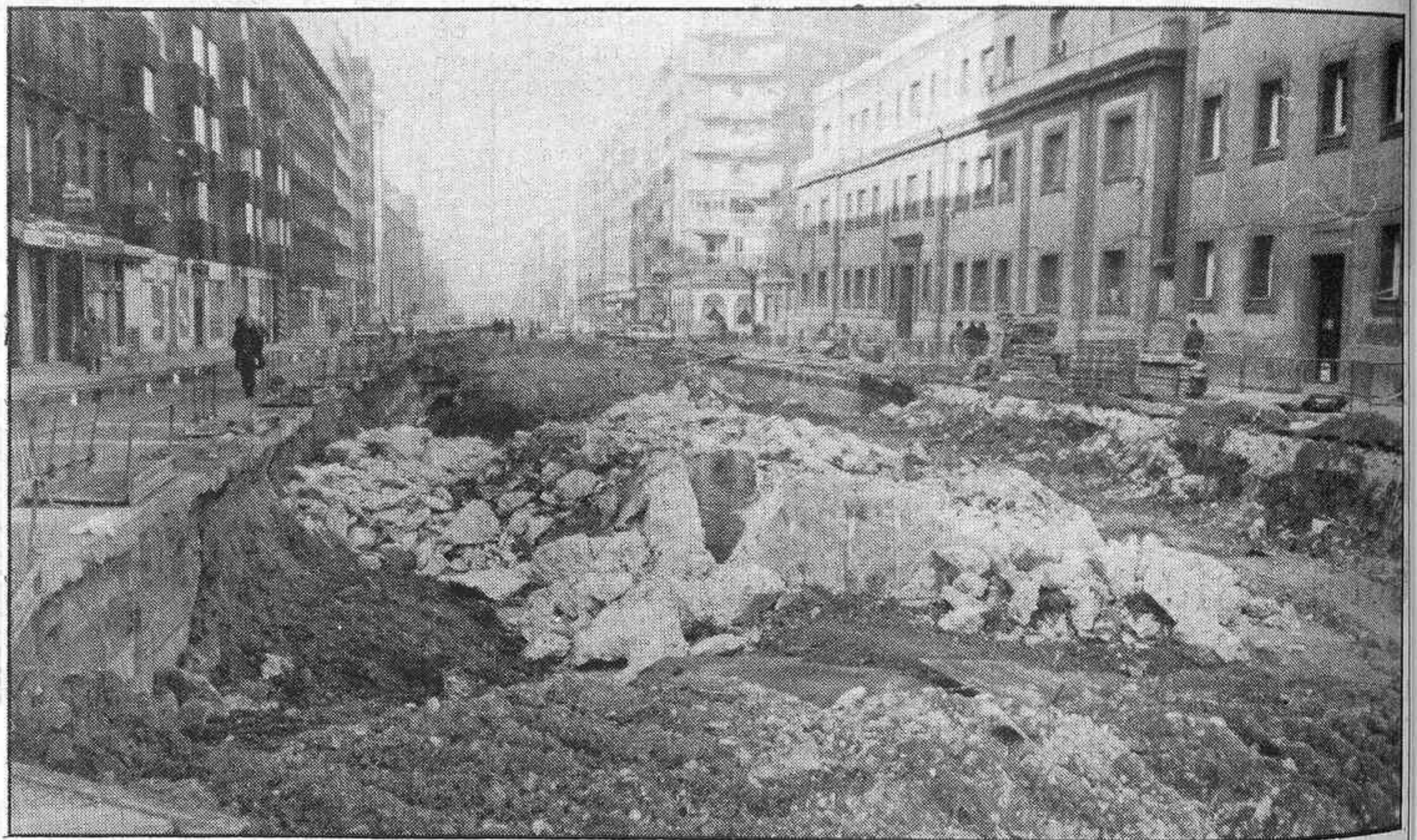
La Ronda de Atocha, totalmente levantada, ya que por esta calle saldrá una de las bocas del subterráneo.
