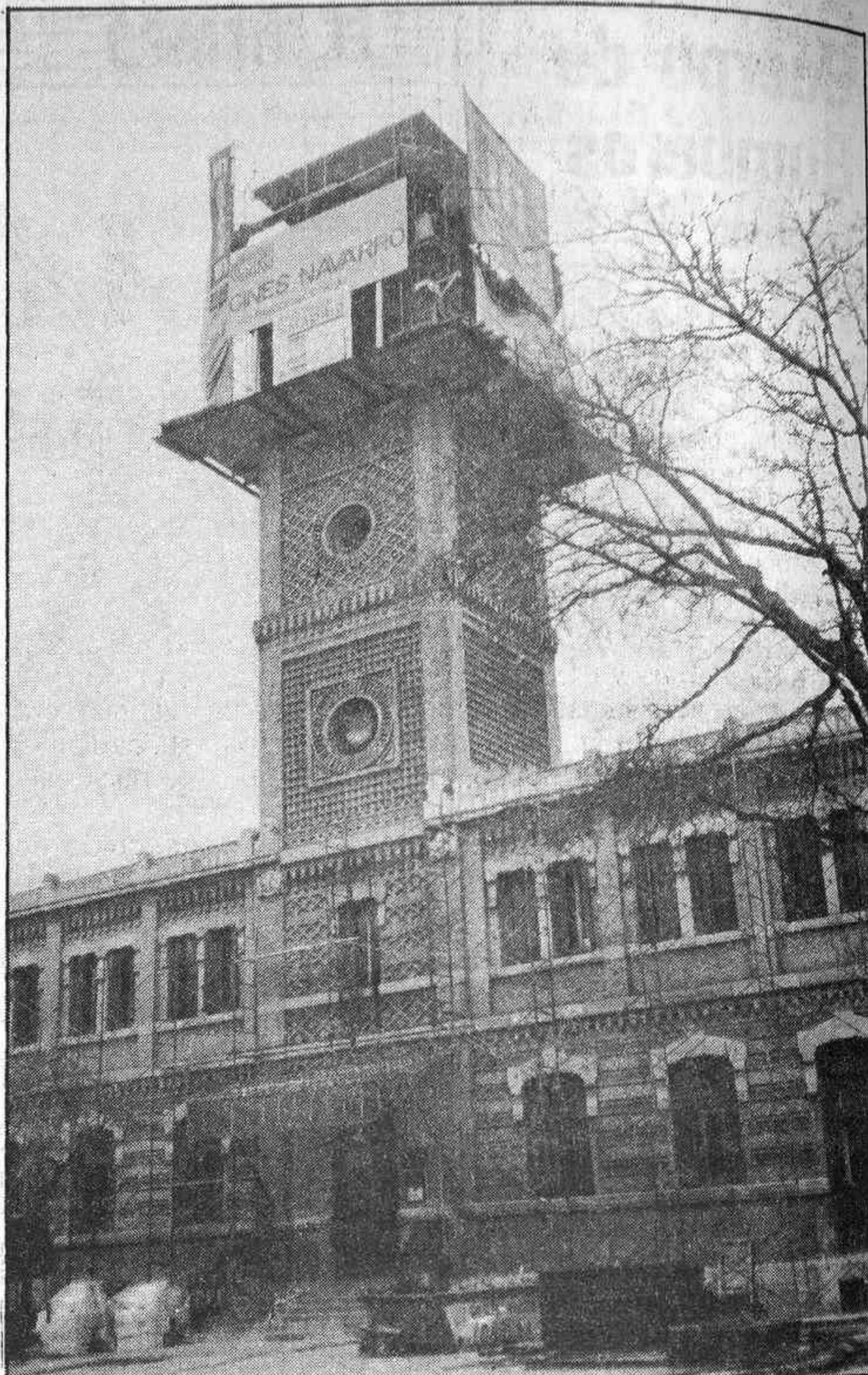
El cuerpo que centra el inmueble, especie de torre-vigía en la encrucijada del edificio frente a la perspectiva de Alcalá y Cibeles —a su pie, la estatua ecuestre del general Espartero—, va a ser cuidadosamente retocada. Así, las antiguas Escuelas Aguirre, que no lo son ya, mantendrán, sin dejar de serlo, su fisonomía primitiva para el recuerdo y quizá la nostalgia de muchos madrileños.
