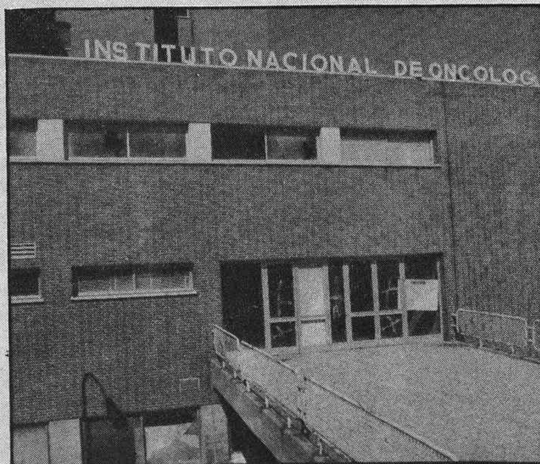
El edificio aldaño al Hospital del Rey, donde se pensó trasladar el Instituto, está aún vacío y sometido a expolios y deterioro.
