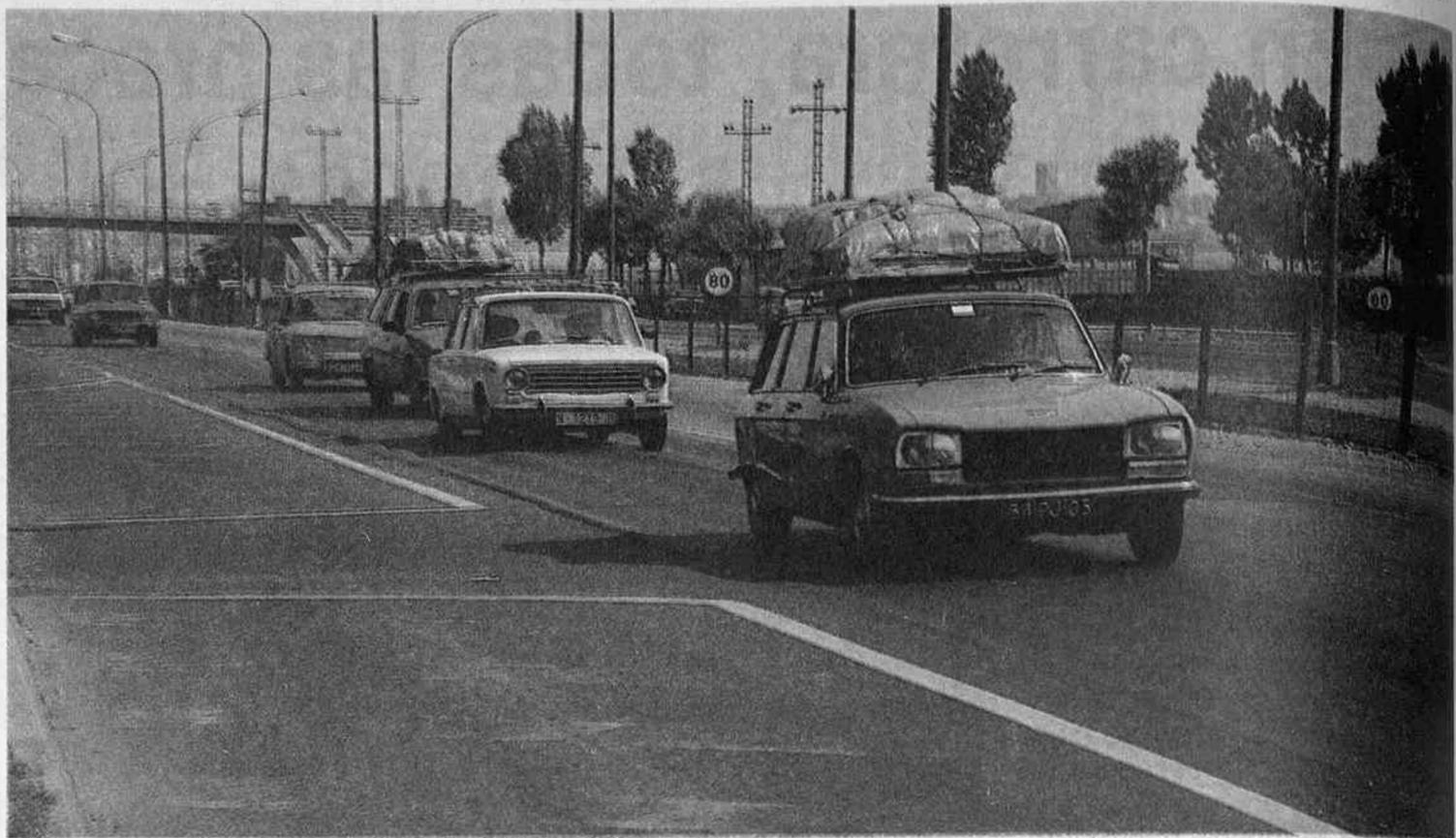
Para una mayor seguridad, la carga debe de ir bien distribuida y, en lo posible, interesa evitar los bultos sobre la baca para mantener una buena estabilidad.
