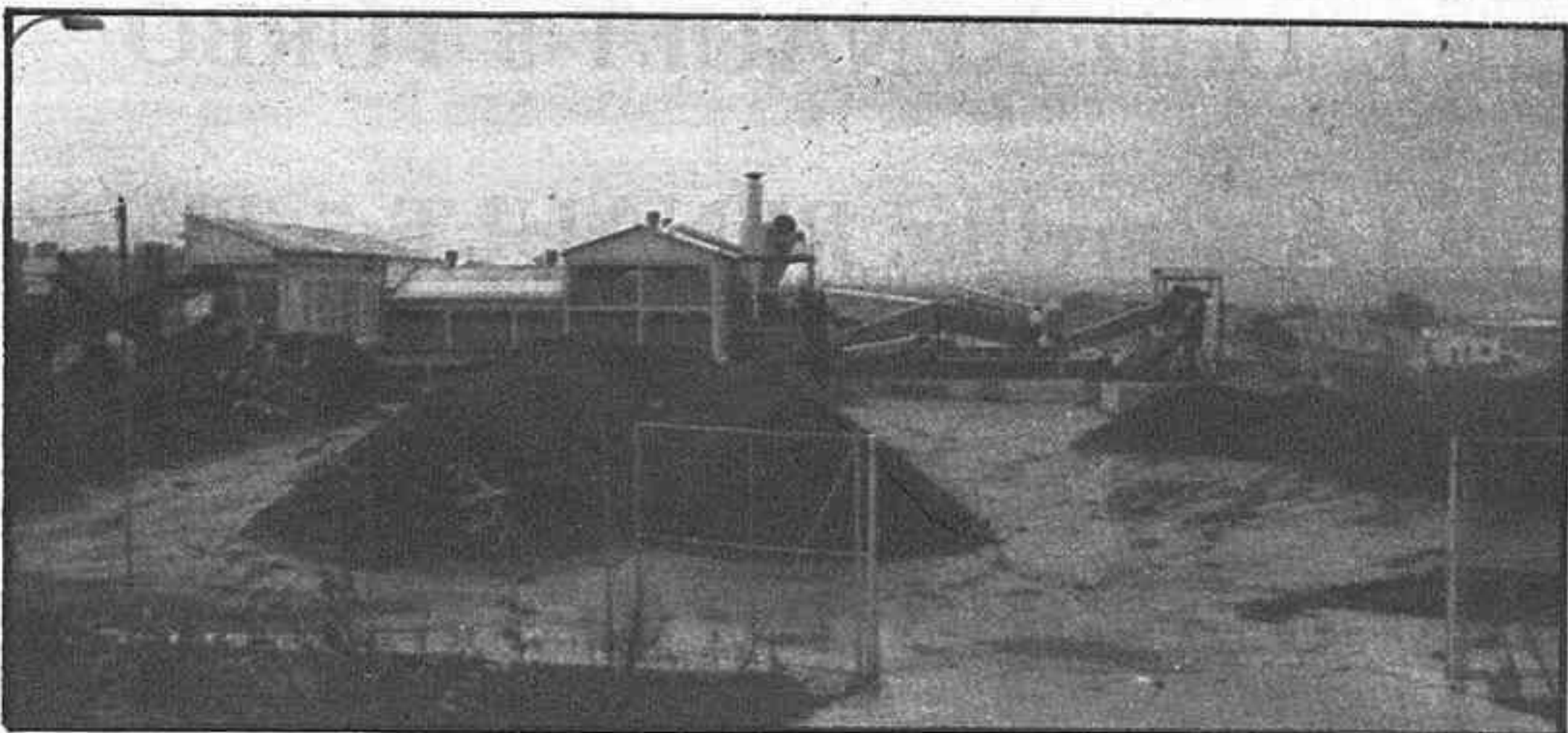
Planta de tratamiento RSU de Tarragona. FOCSA
