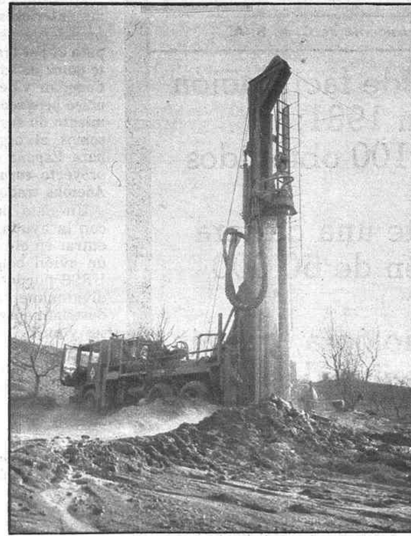
ZAHORI 1.206 trabajando en Querétaro (México) con un diámetro de 17" en terreno volcánico con intercalaciones de cenizas no consolidadas. Profundidad: 200 metros. Caudal obtenido: 60 litros por segundo
