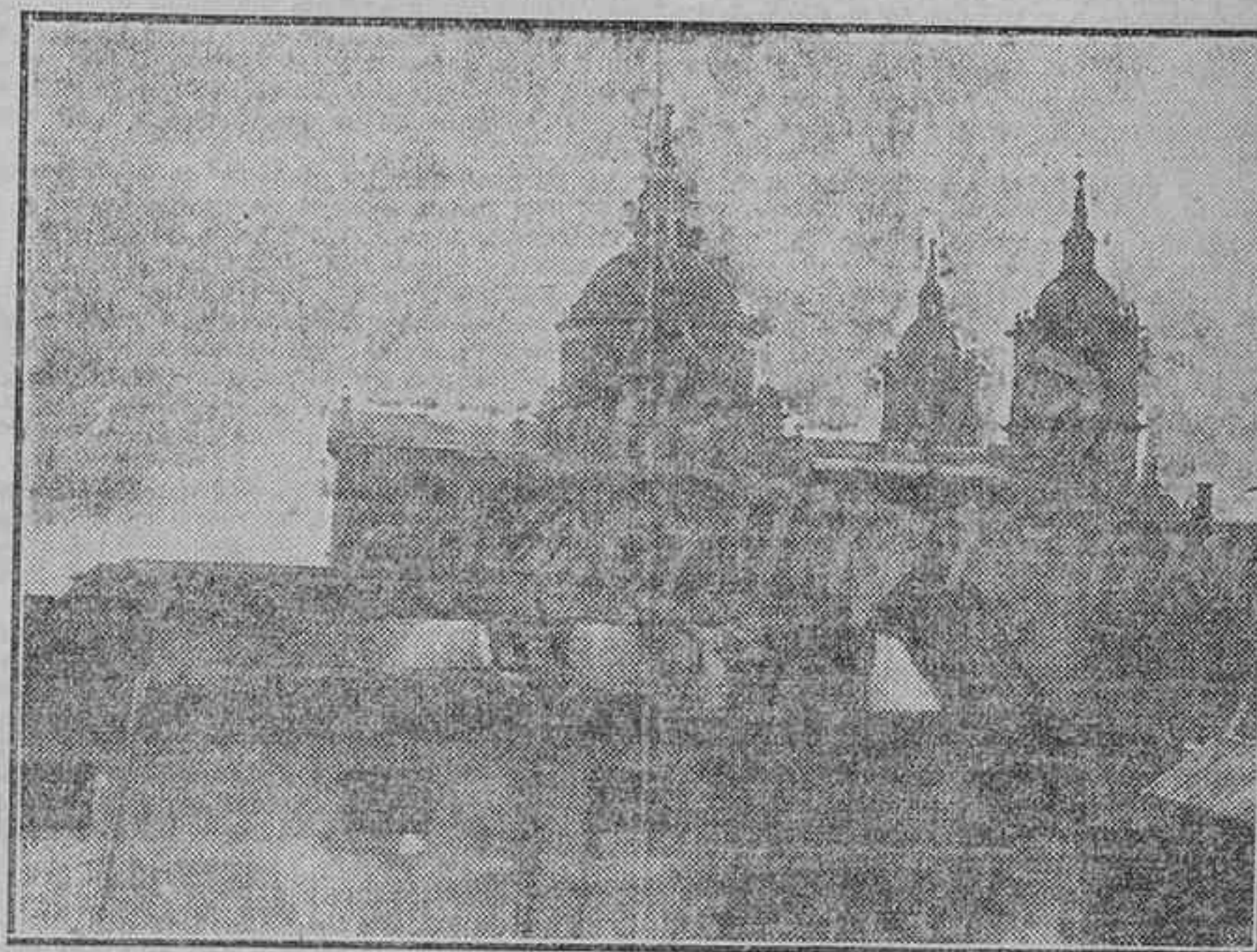
EN EL ESCORIAL.—EN PRIMER TERMINO, EDIFICIO DONDE ESTABA INSTALADA LA CENTRAL DE TELEFONOS, DESTRUIDA POR EL FUEGO
