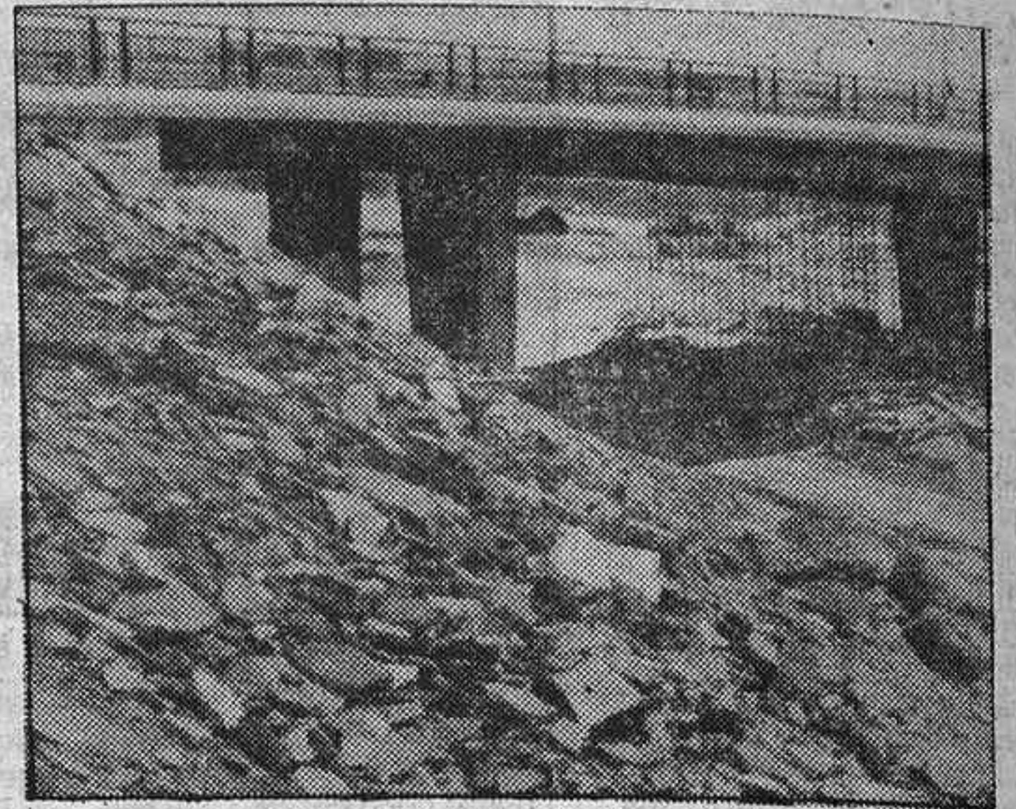
La construcción y ensanche de puentes ha sido una de las acciones prioritarias llevadas a cabo por la Diputación
