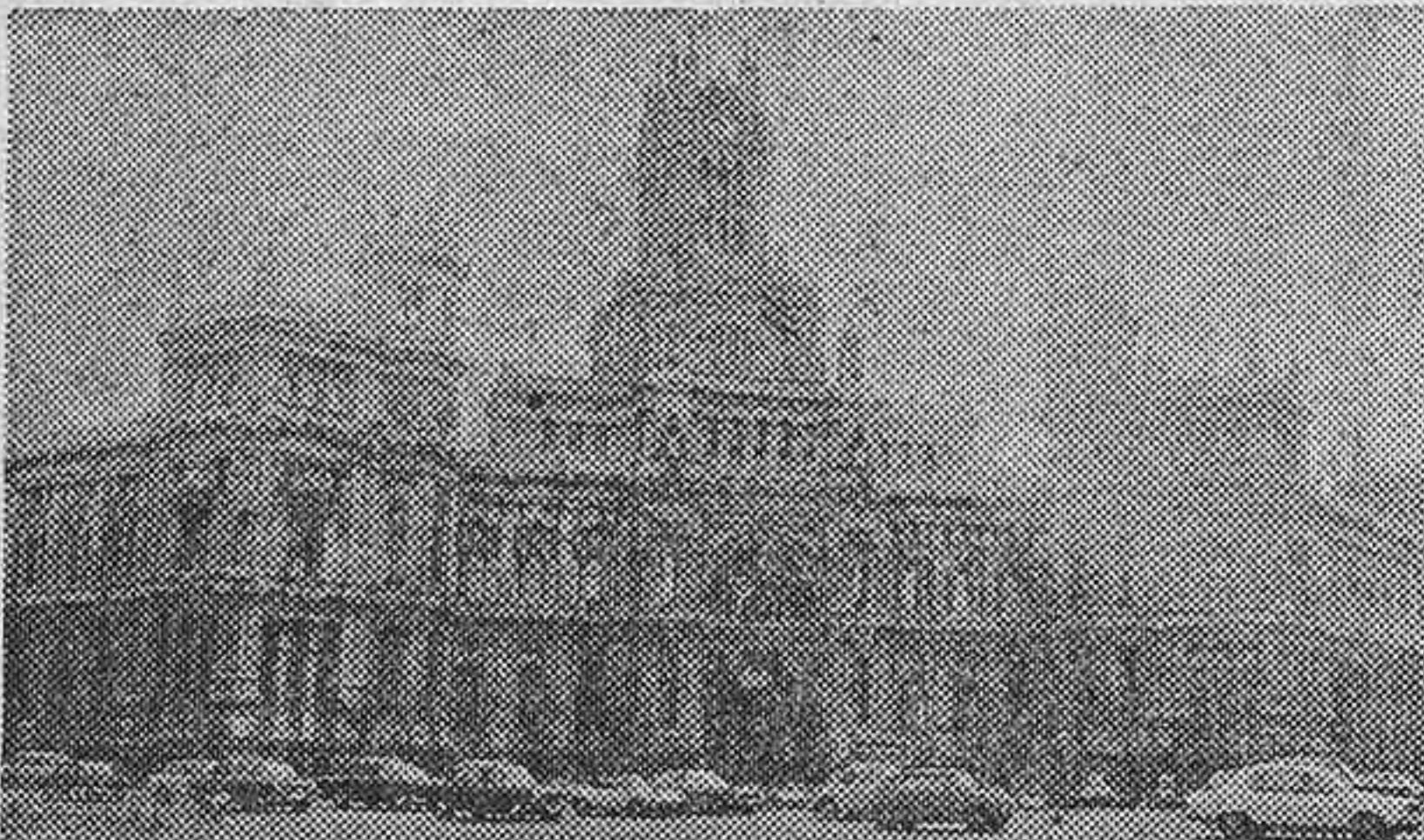
Este gran edificio de activo empaque, que por su estructura y línea casi catedralicias el gracejo madrileño definió un día, con evidente exageración e ingenuidad, pero también sin ánimo alguno que rozase la irreverencia, como Nuestra Señora de las Comunicaciones, tiene entre los servicios de la Administración pública una importante y entrañable función: la de sistematizar trabajos y negocios y vincular sentimientos familiares por medio de toda clase de mensajes. Su vida cotidiana es la de una ciudad mínima inserta en el corazón de la gran urbe. (Foto Torremocha.)
