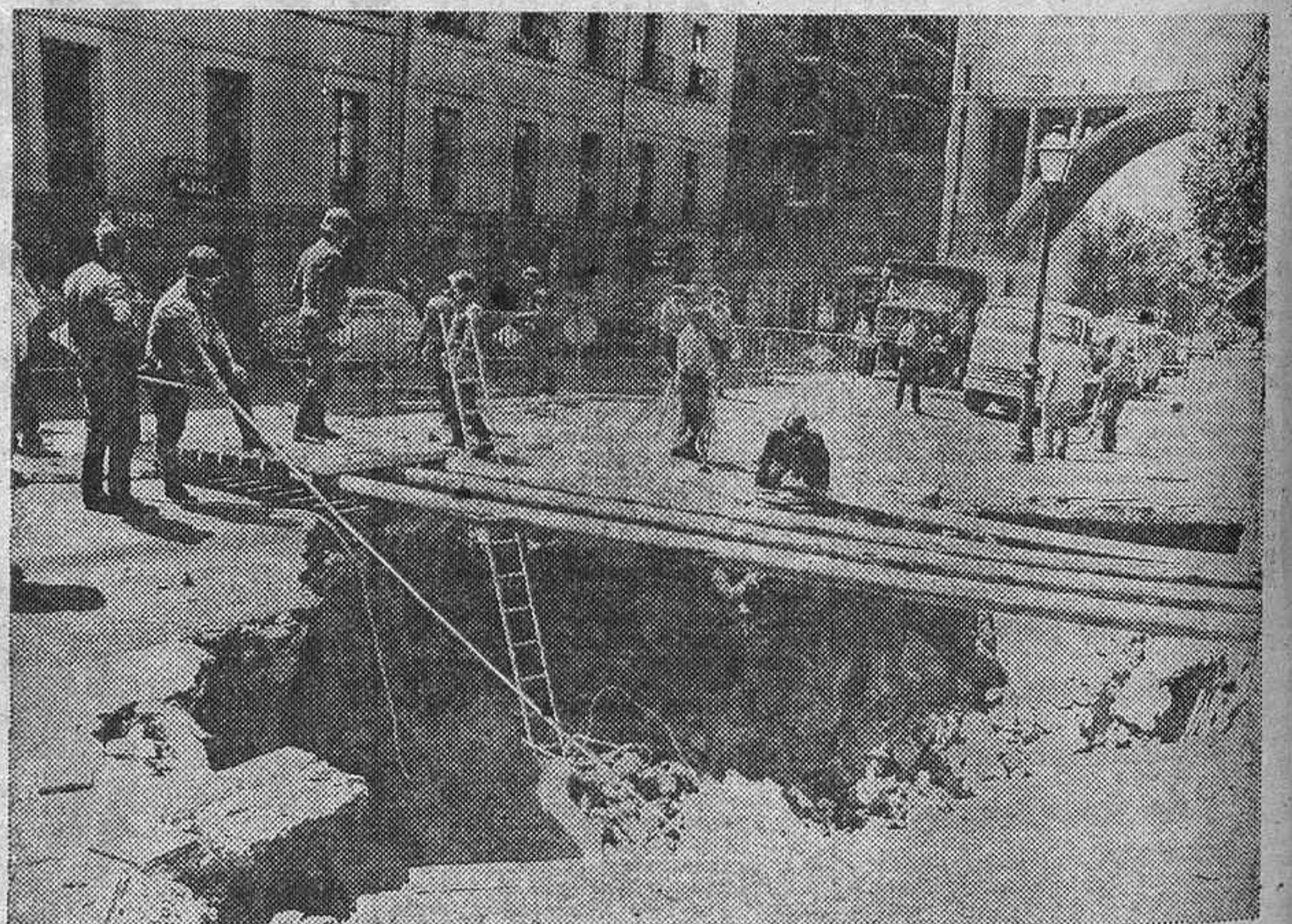
MADRID. (HOJA DEL LUNES.)—Alrededor de las 18,30 horas de ayer se produjo un importante socavón en la calle de Segovia, a la altura de los números 20 y 22. Según nos ha informado la Policía Municipal, este hundimiento podría afectar a las dos fincas citadas. Coches de bomberos y de la Policía Municipal se trasladaron a la citada calle y practicaron un primer reconocimiento de la zona. Al parecer, nada más producirse el socavón se originó un fuerte olor a gas. Como es lógico, el tráfico ha sido desviado por las calles de San Justo, para salir a la calle Mayor, y por la de la Villa.
