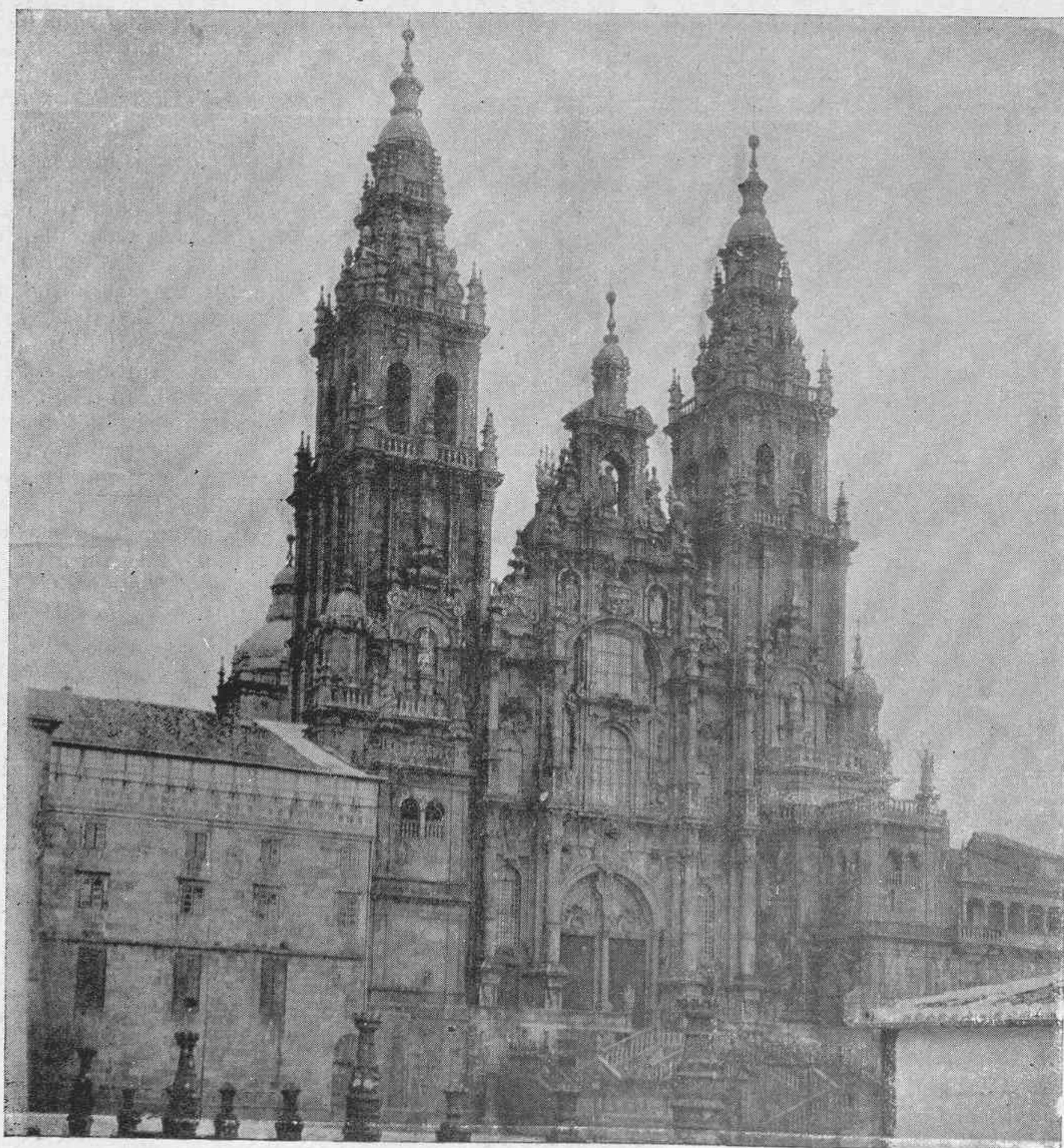
VISTA EXTERIOR DE LA BASÍLICA.
