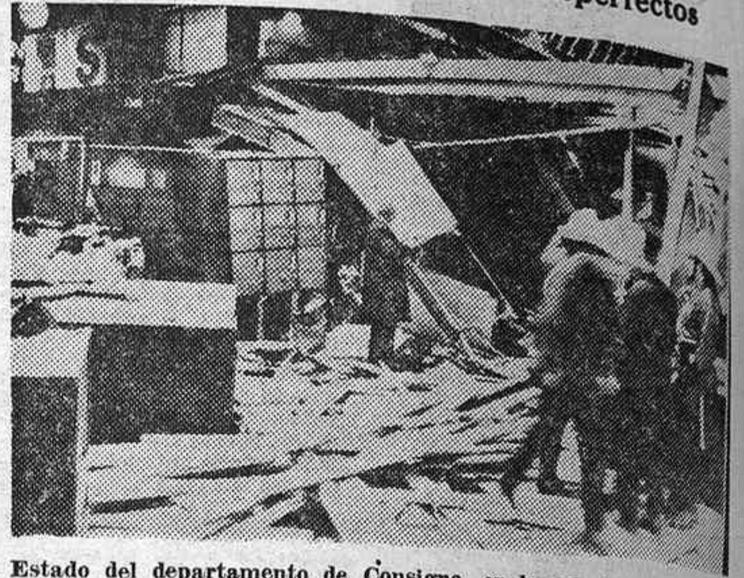
Estado del departamento de Consigna, en la estación de Zurich, tras la explosión. La sección de cajas fuertes quedó intacta. (Telefoto A. P.-Europa Press)
