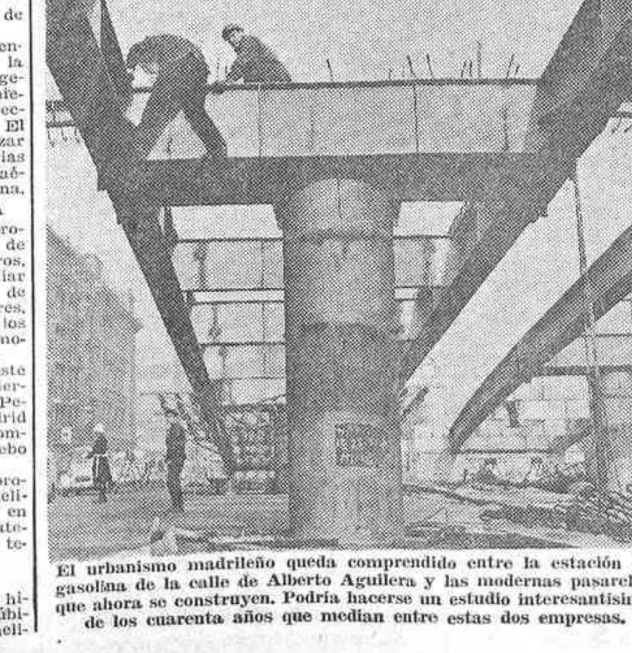
El urbanismo madrileño queda comprendido entre la estación de gasolina de la calle de Alberto Aguilera y las modernas pasarelas que ahora se construyen...
