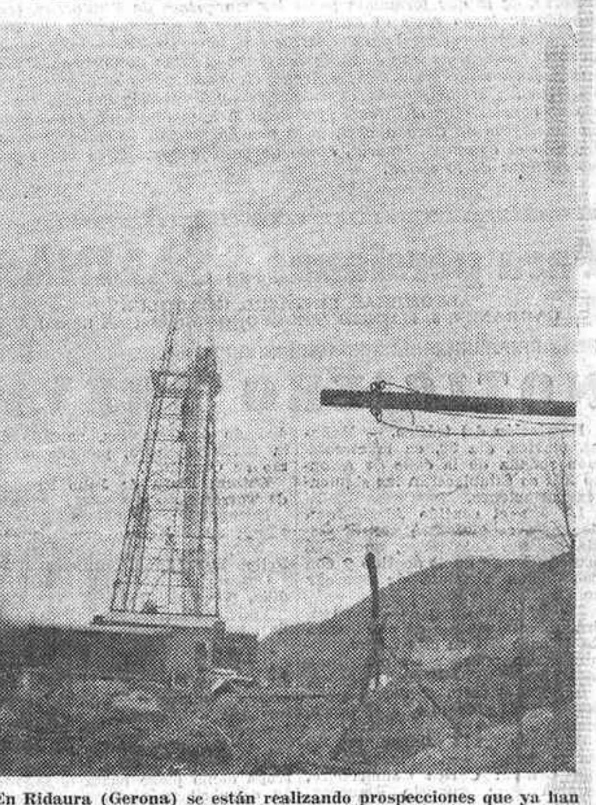
En Ridaura (Gerona) se están realizando prospecciones que ya han dado gas natural. Para el próximo abril se espera alcanzar los 3.000 metros de sondeos profundos. (Foto Fiel.)
