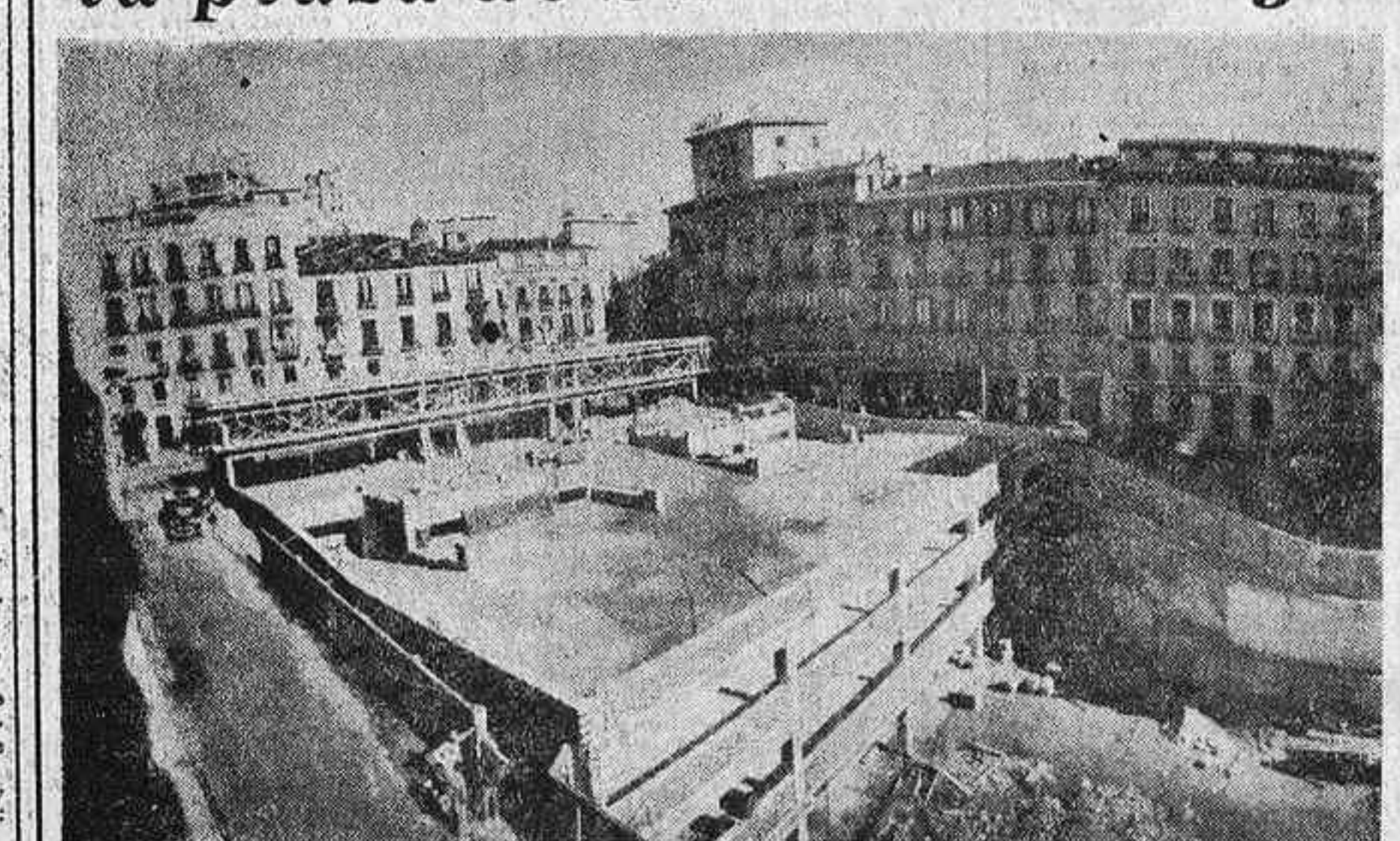
Fase a las vallas que la cercan, puede apreciarse cómo quedará la plaza de Santo Domingo una vez terminadas las obras, que ya tocan a su fin. A principios de mes tendremos allí un estacionamiento de coches que alivie el contorno de la Gran Vía más congestionada de tráfico, y aunque no será suficiente para lo que Madrid necesita, por algo se empieza. Sobre todo, se efectúa la transformación de la plaza de Santo Domingo, construye el Municipio el aparcamiento proyectado en la calle de Tudescos. (Foto Godoy.)
