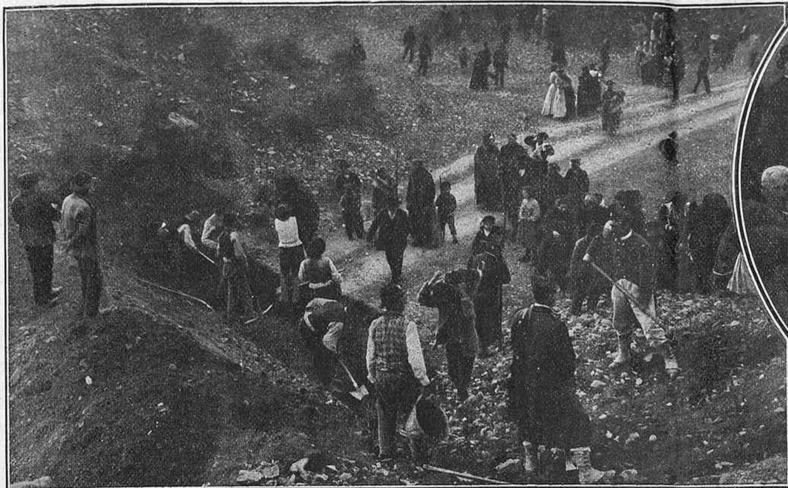
LOS HABITANTES DE BOSCOTRECASE CONSTRUYENDO TRINCHERAS PARA DESVIAR LA LAVA
