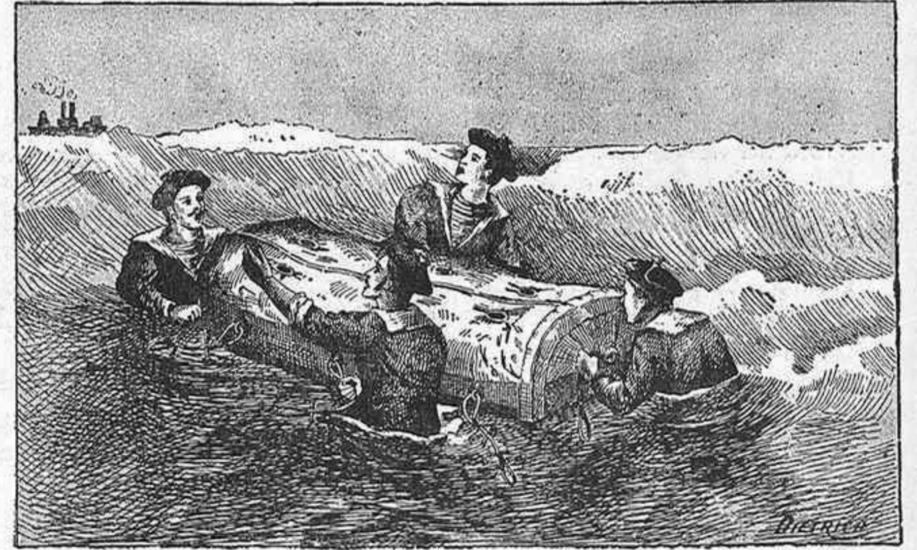
Fig. 3. - Boya reductible henchida con aire para el salvamento
