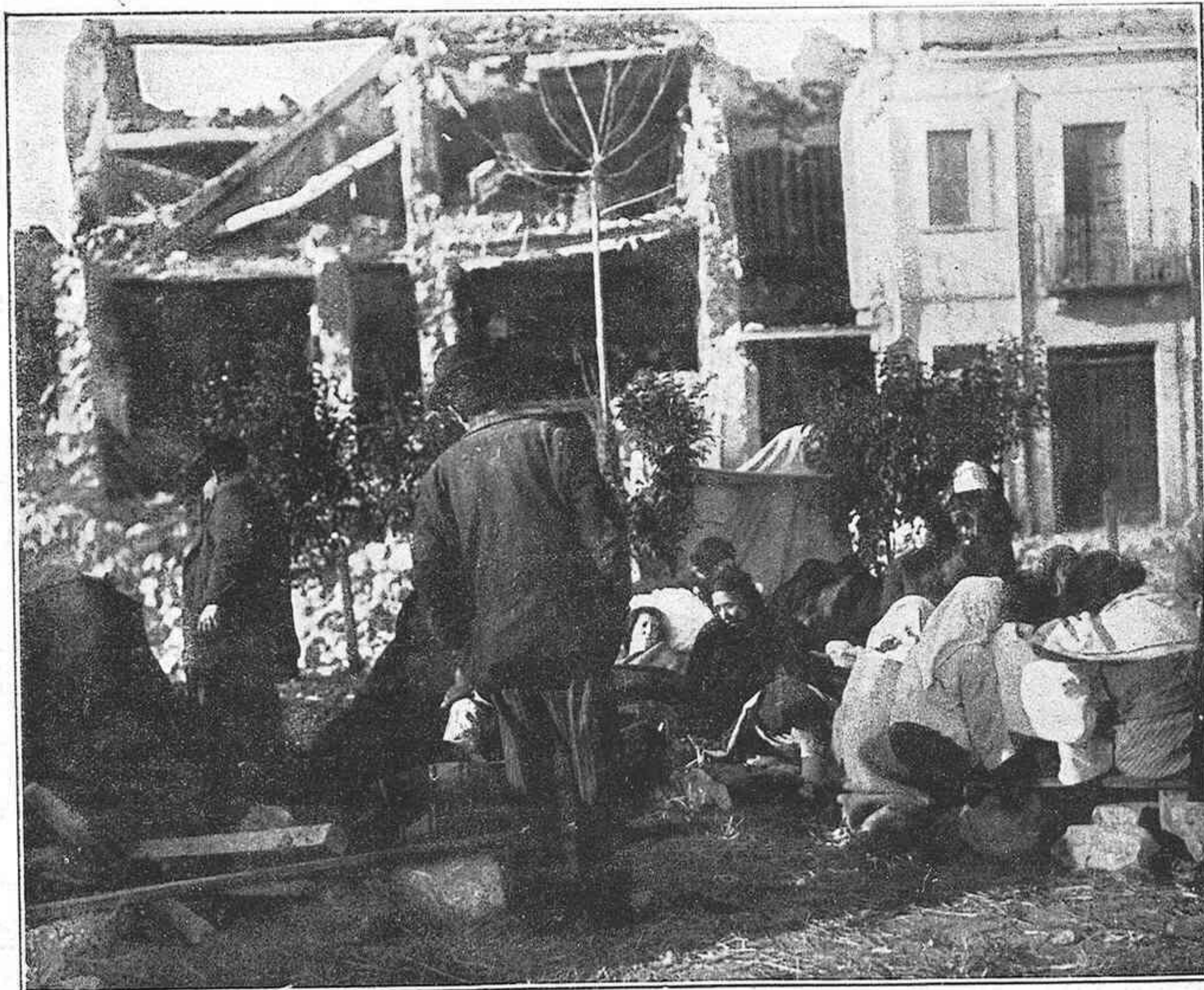
Habitantes de Avezzano acampando entre las ruinas
