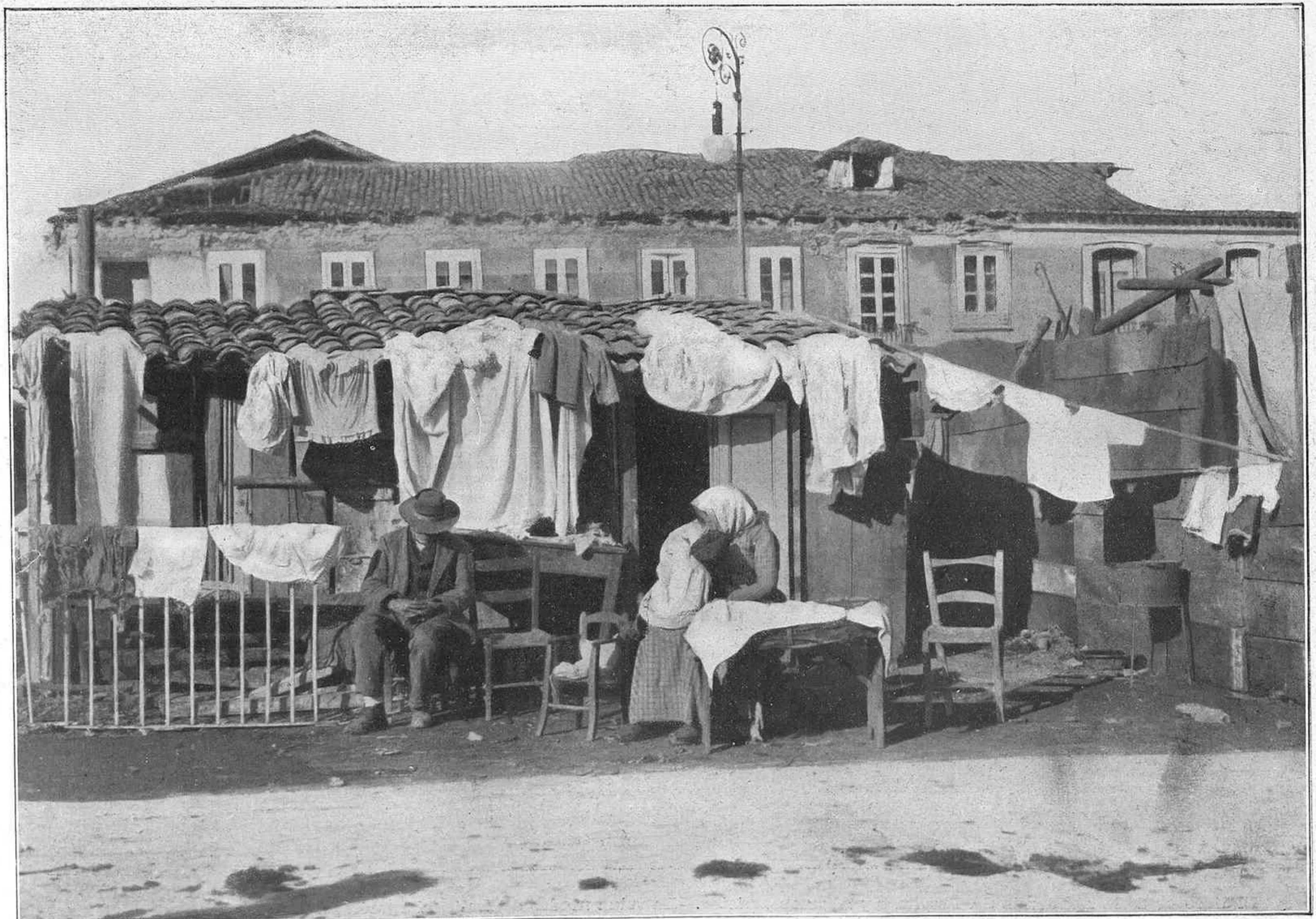
Santa Eufemia.—Familia albergada en una barraca construída con materiales extraídos de las ruinas y de tan reducidas dimensiones, que ni siquiera puede contener el miserable mobiliario de sus moradores
