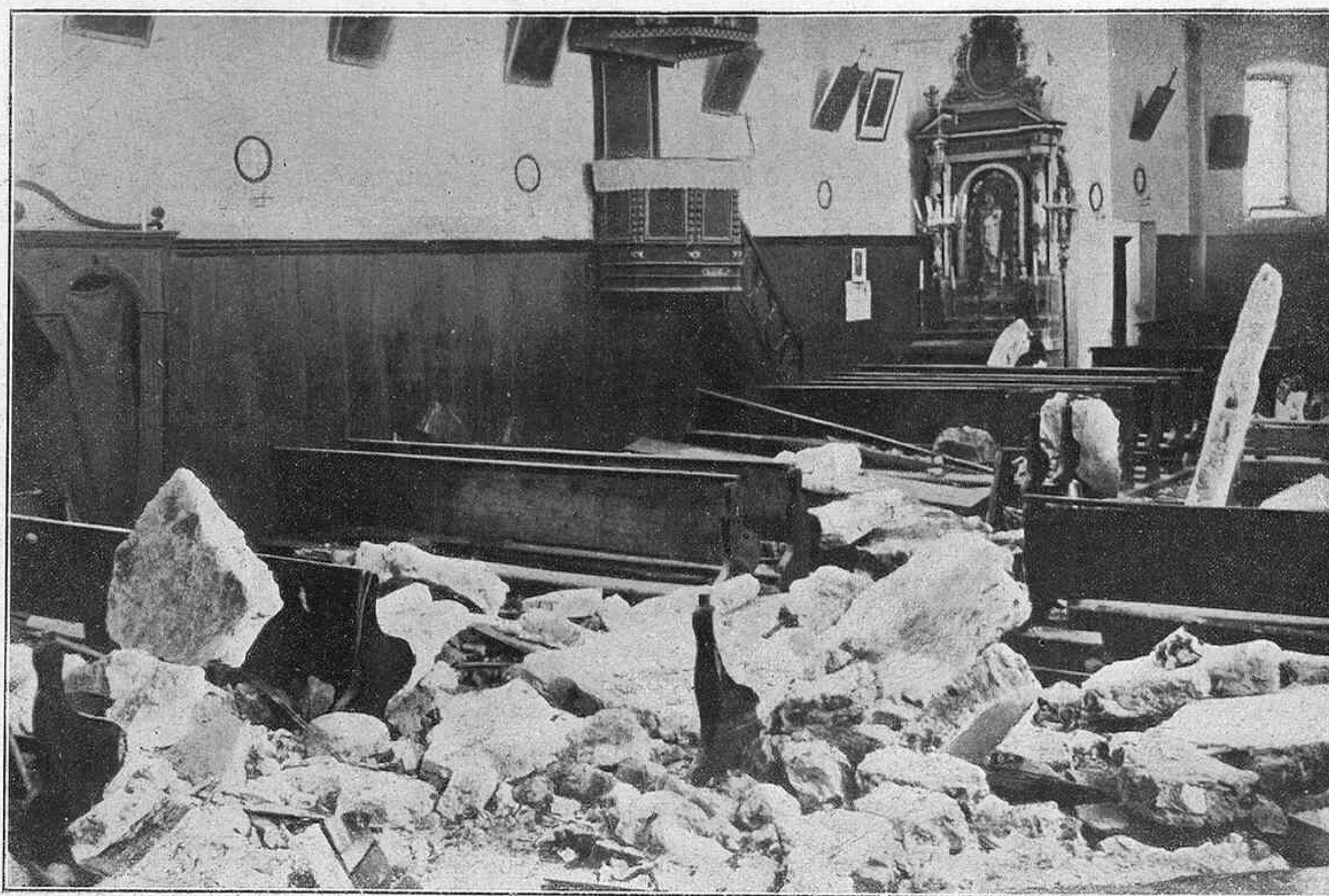
Vista interior de la iglesia de Nax (Suiza) después del hundimiento de la bóveda, á consecuencia del cual murieron 31 personas y quedaron heridas 50, en su mayoría muy gravemente (De fotografías de C. Delius.)
