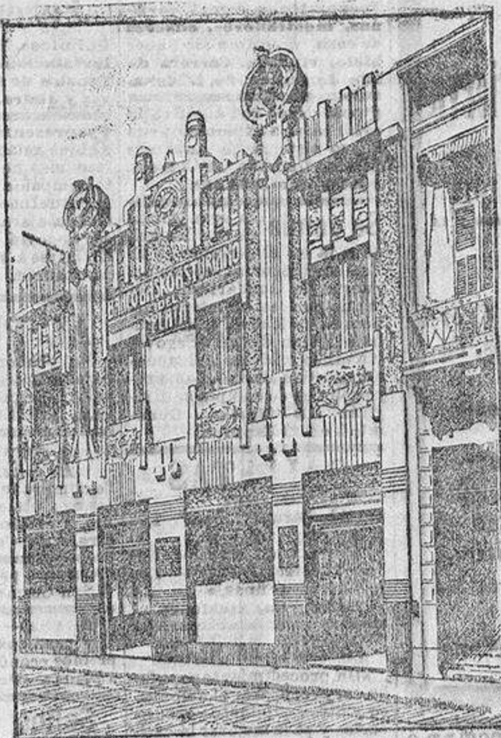
EDIFICIO DEL BANCO
