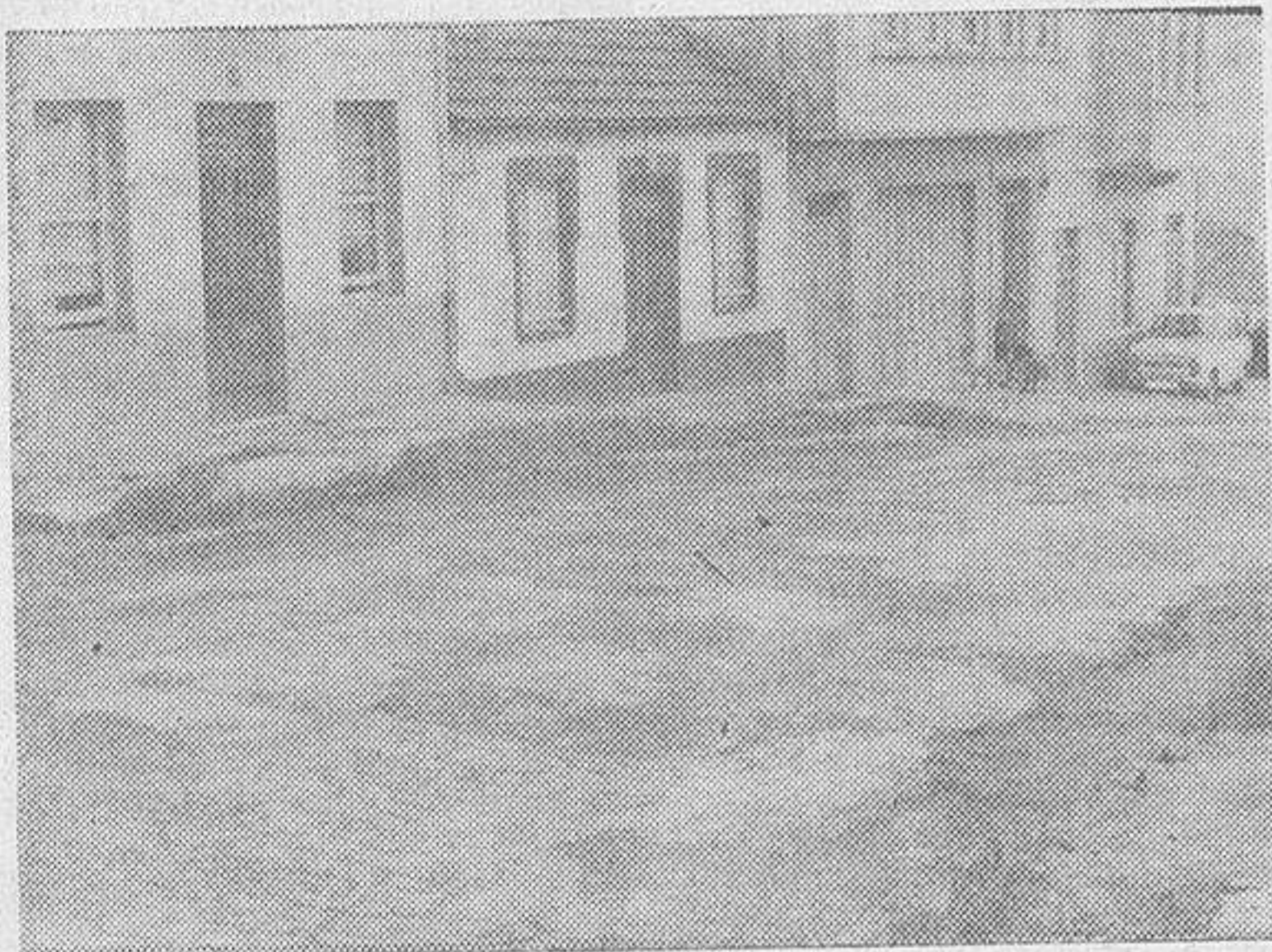
Una de las vías que conducen a Serantes, con socavones y mal rebachada.
