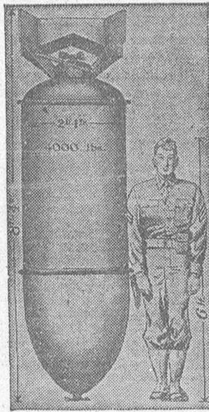
Dimensiones de una bomba de aviación de 2.000 kilos comparadas con la de un soldado. Deduzca el lector lo que será una bomba de 6.000 kilos como las recientemente empleadas.
