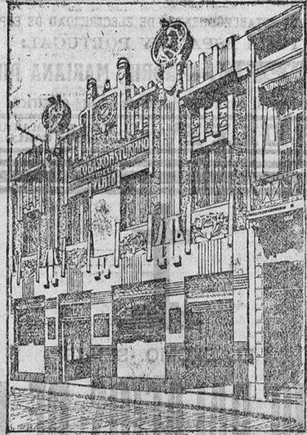
EDIFICIO DEL BANCO
