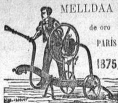
Bomba rotativa para el trasiego del vino, más apreciada que ninguna otra á causa de la sencillez y de la solidez de su mecanismo.
