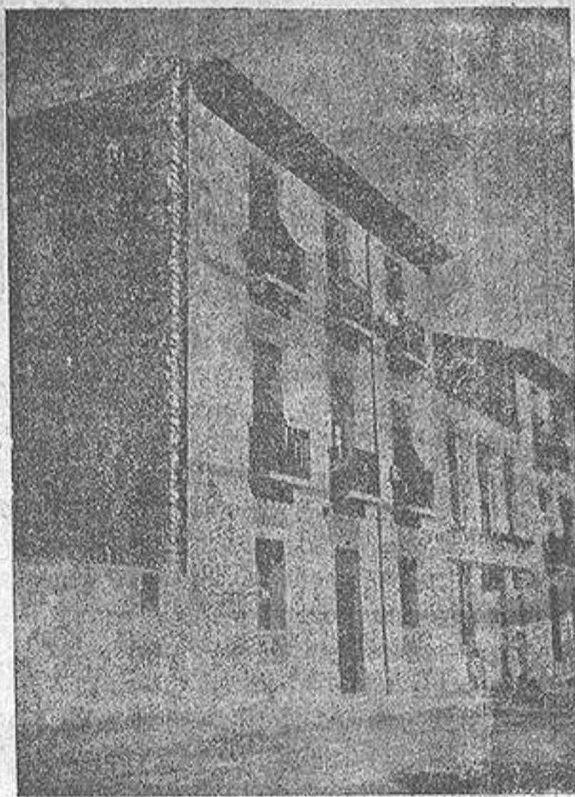
en casas ya edificadas y cuyo coste puede ser mucho mayor que el real.
