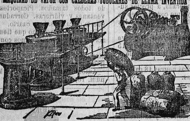
MAQUINAS DE VAPOR CON CALDERAS TUBULARES DE LLAMA INVERTIDA.
